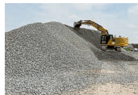
Für die Arbeiten auf der Riedbahn wird viel Schotter benötigt: 380 000 Tonnen.
